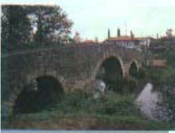
Puente romano de Furelos
